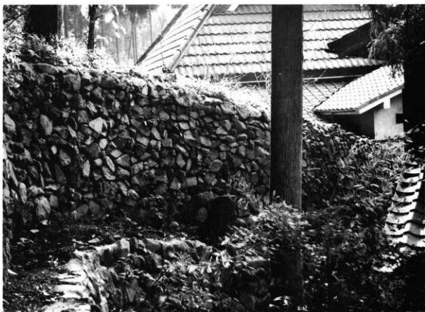
2 調査前の現状（北から）
