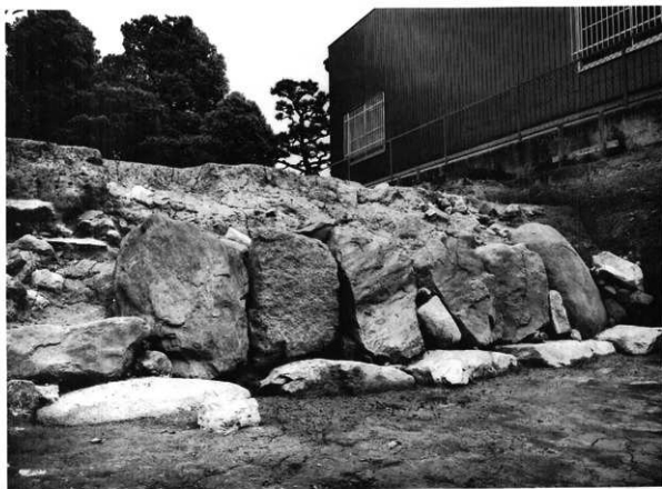
2 第122次調査 堀・石垣細部(南西から)
