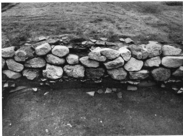
1 基壇北側 石積と瓦積（北から）
