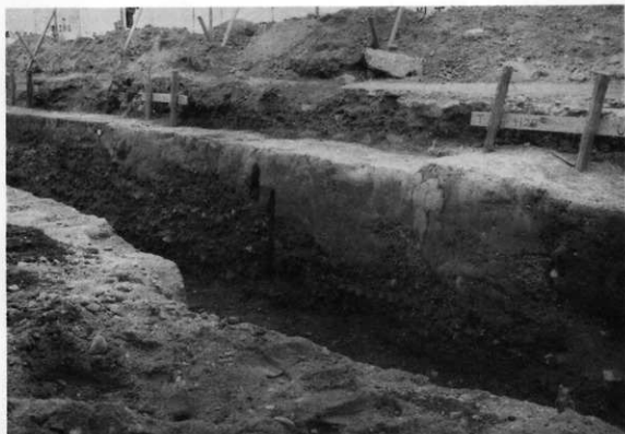
2 SD1断面 (西南から)
