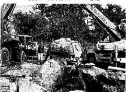
写真7 天井石のクレーンによる設置
