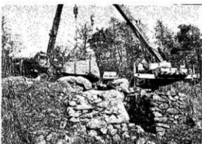
写真6 天井石のクレーン移動
