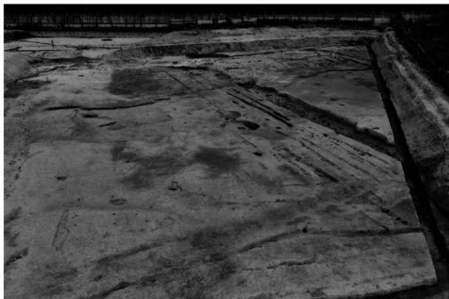
(1) 第4・5次調査区全景(西から)
