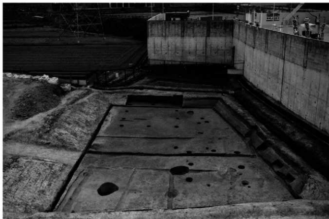
(1) 第4・5次調査区全景(北から)
