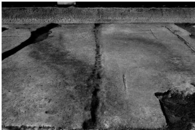
(1) 道路 S F 1 西側溝 S D 190 (南から)
