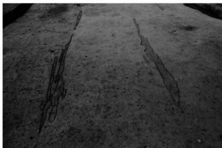
(2) 道路 S F 1 轍痕検出状況 (南から)
