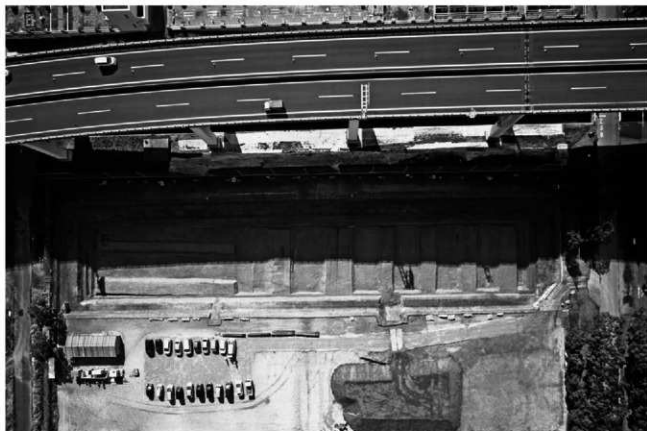
(1) 調査地(第 1 面)全景(上空から:下が北)
