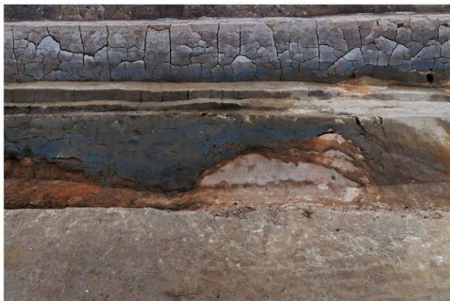
(2)地震痕跡近景(東から)
