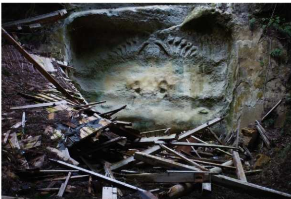
写真1 東日本大震災被害状況(1)
