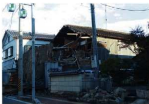
写真5 東日本大震災被害状況(5)
