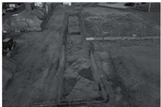
2地点B区 全景
