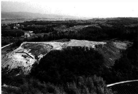
(1) 調査前全景 (北から)
