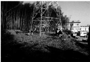
第5図 調査地全景（南から）
