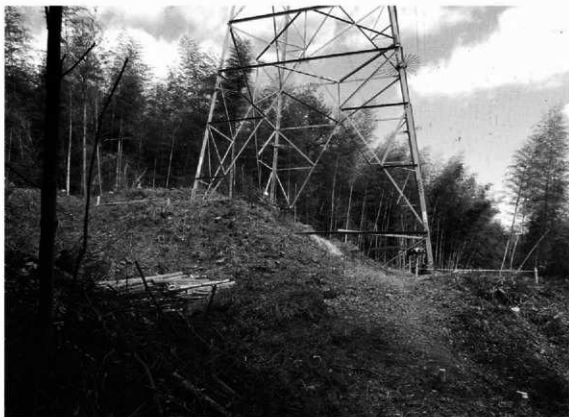
第36図 210号鉄塔（西から）
