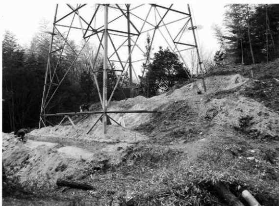
第37図 210号鉄塔調査後（東から）
