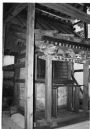
白山神社本殿（重要文化財）
