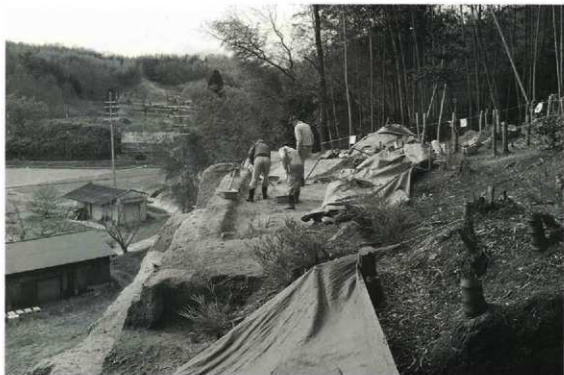
作業風景（東から）
