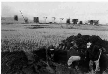
作業風景(48トレンチ)
