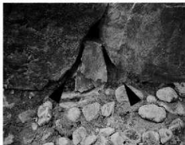
第44図 1号墳玄室側壁目地の灰白色粘土 (北東から)
