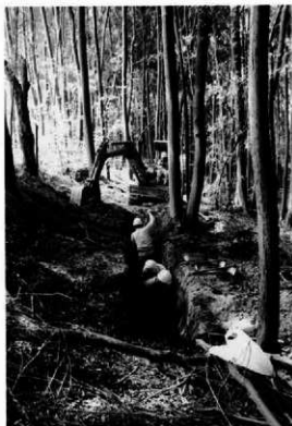
第6図 試掘調査風景（南から）
