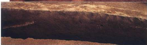
旧道跡 土層堆積状況
