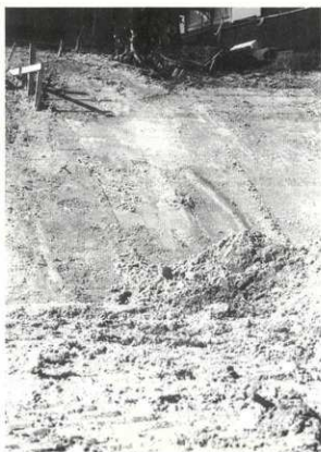
③工事中風景（北東から）
