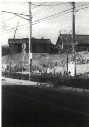
②工事中風景（北東から）
