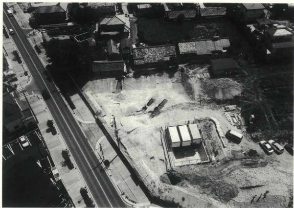
①遺跡遠景（北東上空から）
