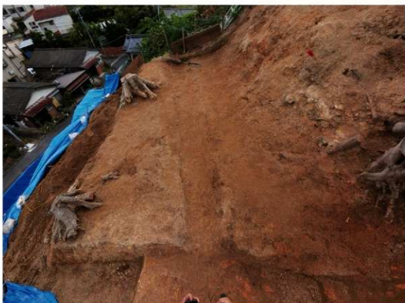
2区 II-3期 腰郭9 (北西から)
