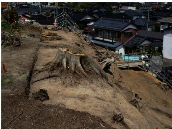
Ⅲ期 頂部平坦面（南東から）
