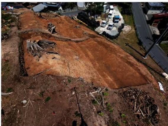
Ⅱ-2期の遺構面検出状況（南東から）
