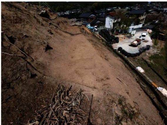
Ⅲ期 溝3 (南東から)
