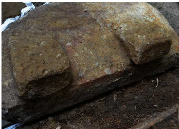
家形石棺 南側蓋石 東側縄掛突起周辺の剥離状況（南東から）
