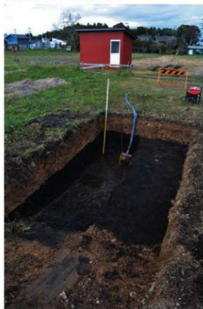
写真 32 8 T 調査状況
