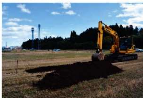
写真 26 重機掘削状況
