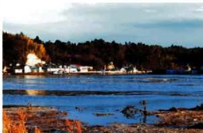
写真6 東日本大震災被害状況（6）
