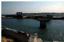
写真2 東日本大震災被害状況 (2)
