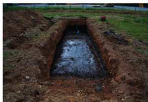
写真 27 1 T 調査状況
