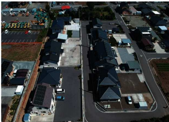
写真 55 B地区施工後近景
