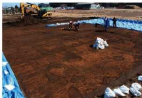
写真 46 B地区 遺構確認作業
