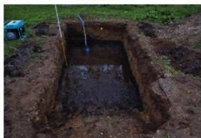
写真 29 3 T 調査状況
