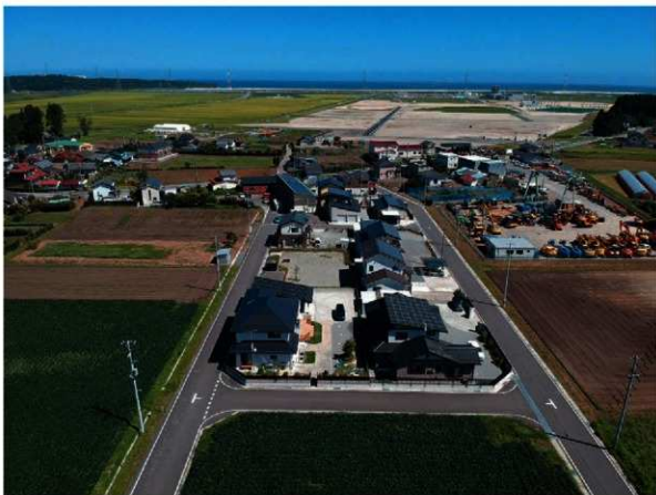
写真 53 A地区施工後近景
