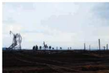
写真3 東日本大震災被害状況 (3)
