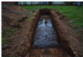
写真 33 2 T 調査状況
