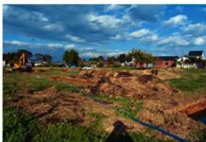
写真 25 重機掘削状況
