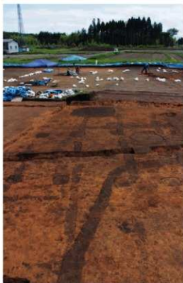
写真 140 19号掘立柱建物跡 検出状況
