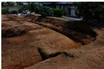
SD1 西から南 (北西から)
