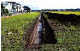
写真8 沖代地区条里跡52次Aトレンチ(西から)
