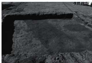
松山遺跡第 99 地点堀状遺構プラン確認
