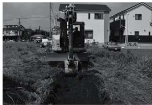
ハケ遺跡第 24 地点試掘調査風景
