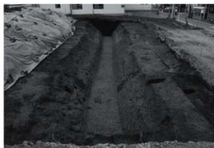
駒林遺跡第 35 地点掘跡完掘
