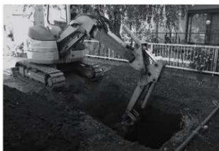
西ノ原遺跡第 166 地点調査風景
