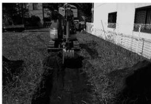
亀居遺跡第 76 地点調査風景
