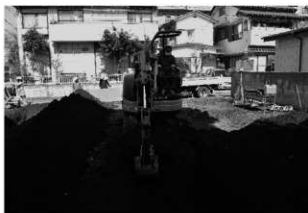
亀居遺跡第 77 地点調査風景
