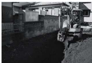
滝遺跡第 27 地点調査風景
