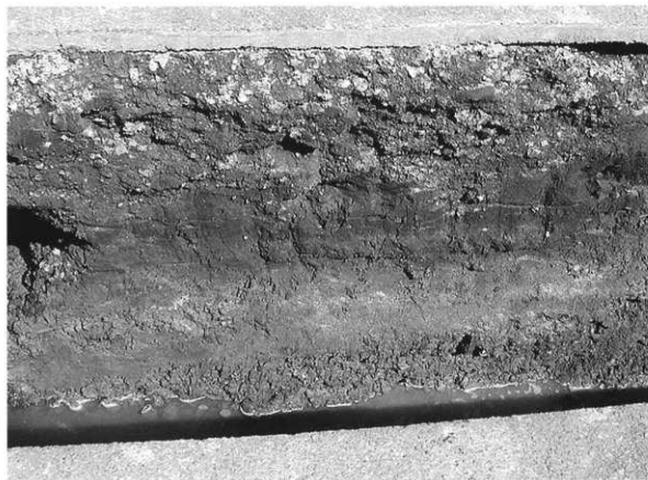
図29 B-B間落込(南から)
