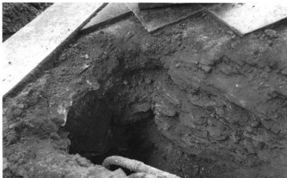
図70 五大堂基壇断面（北西から）
