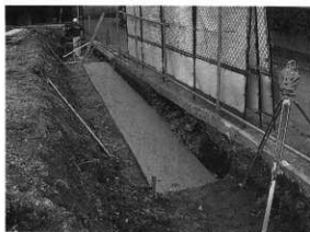
図29 ビット2（南東から）
