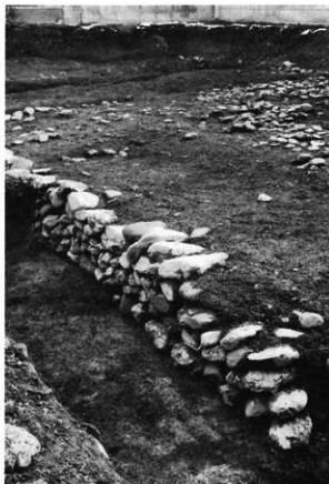
建物地業断面 (南東から)
