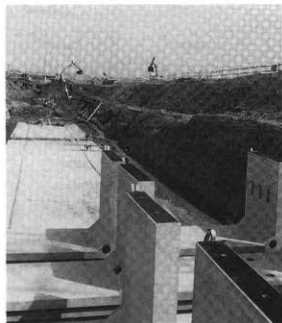
図100 Na5・6全景(南から)
