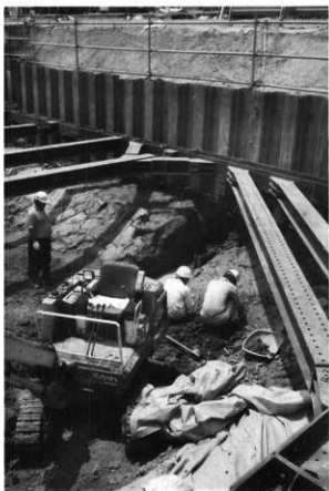
2 No 2地点 全景 (北東から)
