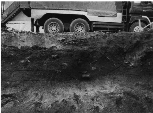
No.2 地点断面 (北から)
