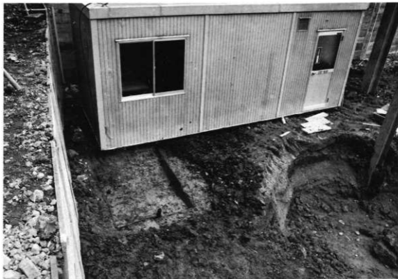
1 水溜遺構完掘状況とNo.2地点(東から)
