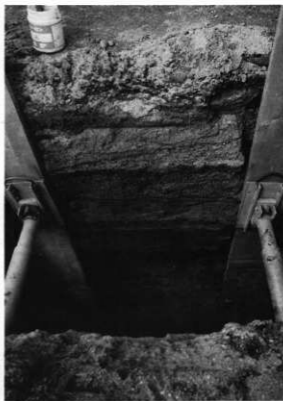
3 152-22地点 掘削断面 (南から)
