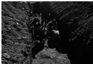
西遺跡第3地点調査風景
