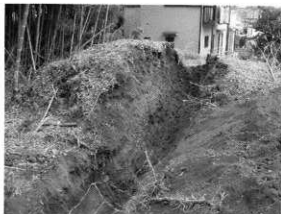
写真10 7トレンチ全景（西から）
