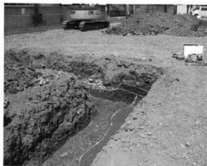
写真 11 2T・3T 溝1 検出状況 (南東から)
