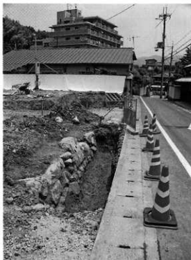
写真14 石垣検出状況（西から）
