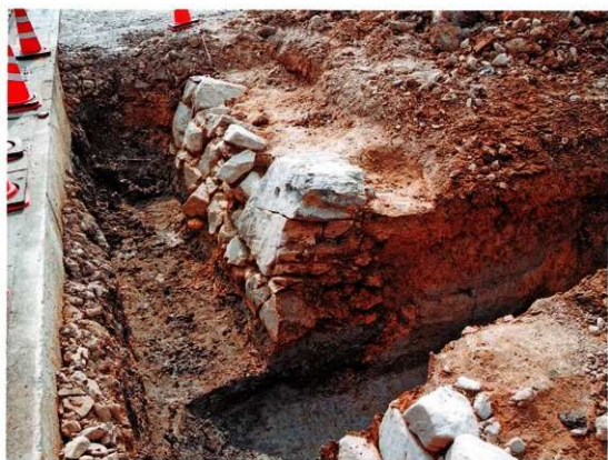
写真2 伏見城跡検出石垣（東から）
