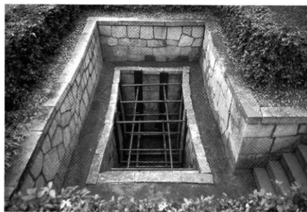
写真5 改修工事前の氷室全景(北から)
