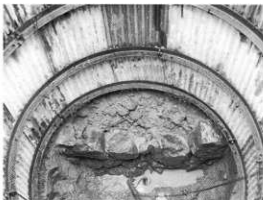
写真13 3区石垣検出状況(北東から)
