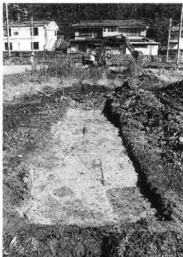
写真17 11トレンチ全景 (南から)
