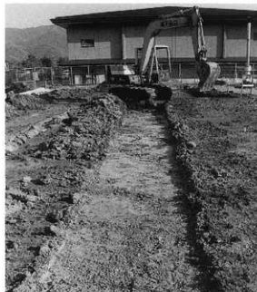
写真13 1トレンチ全景 (西から)
