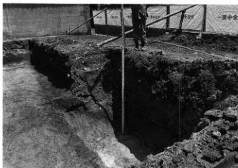
写真11 トレンチ写真 (南から)
