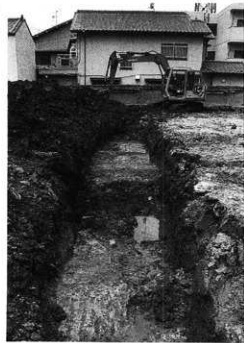
写真10 3トレンチ全景(東から)
