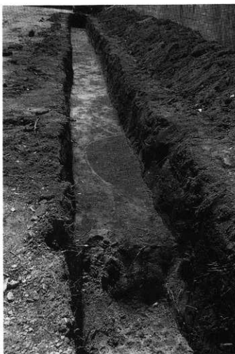
写真9 1 トレンチ全景 (北から)
