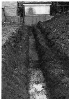
写真5 2トレンチ完掘状況 (東から)
