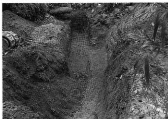
写真10 4トレンチ完掘状況(南東から)
