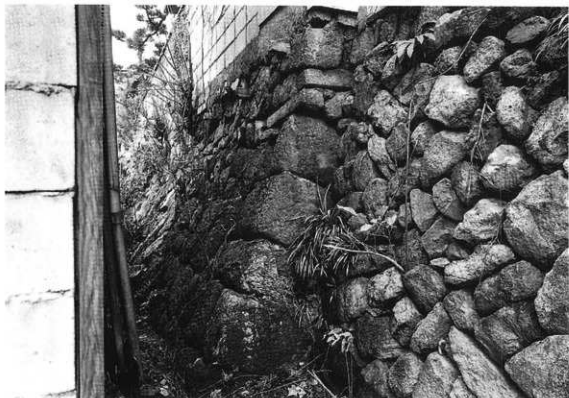
写真1 現存石垣（東から）
