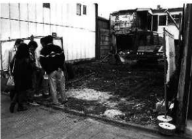
写真2 試掘調査前(東から)
