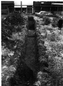
写真14 トレンチ全景（北から）
