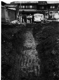
写真11 トレンチ全景（東から）
