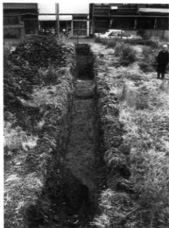
写真14 トレンチ全景（北から）
