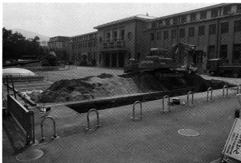
写真9 西トレンチ全景と勤業館（西北から）
