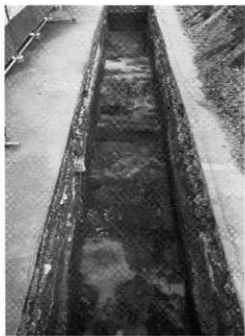
写真10 西トレンチ全景（南から）
