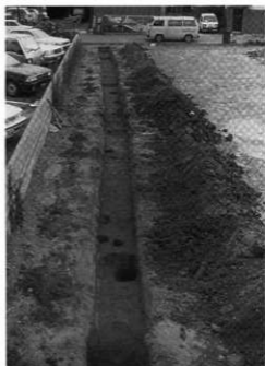
写真25 東試掘トレンチ全景（北から）
