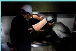
塚原古墳群内石室古墳の被災状況確認作業
